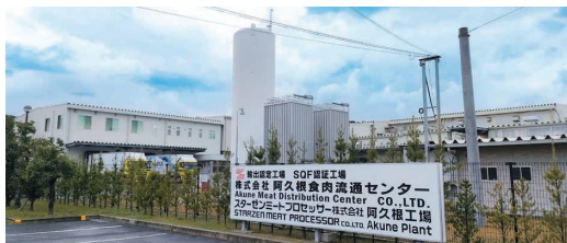
新設したLNGタンク(左側の白い塔)
